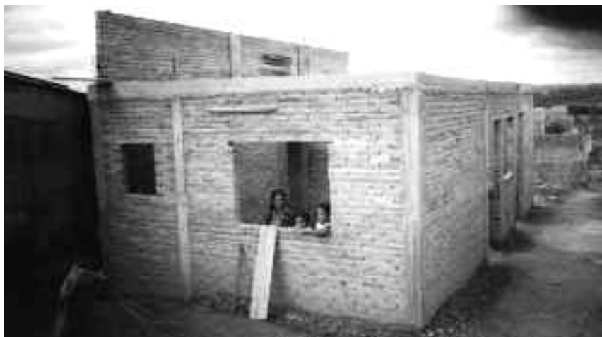
LA CASA IN COSTRUZIONE DI CECILIO E AMMANTINA.
