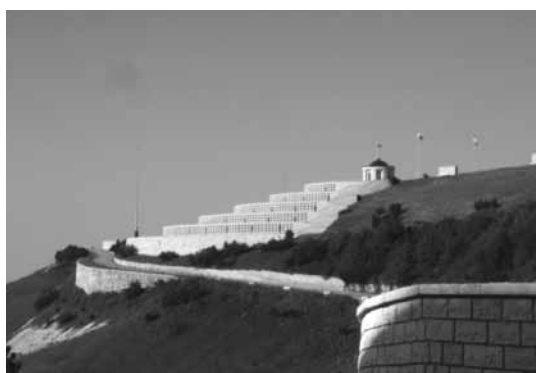
Il Monumento Ossario visto da est
