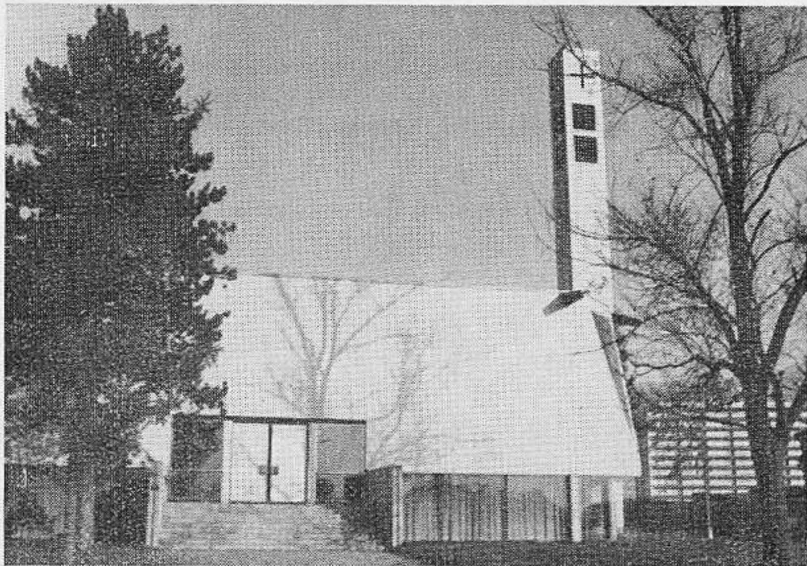
Esterno della stessa Chiesa, eretta ad Innsbrück, in onore di S. Pio X
